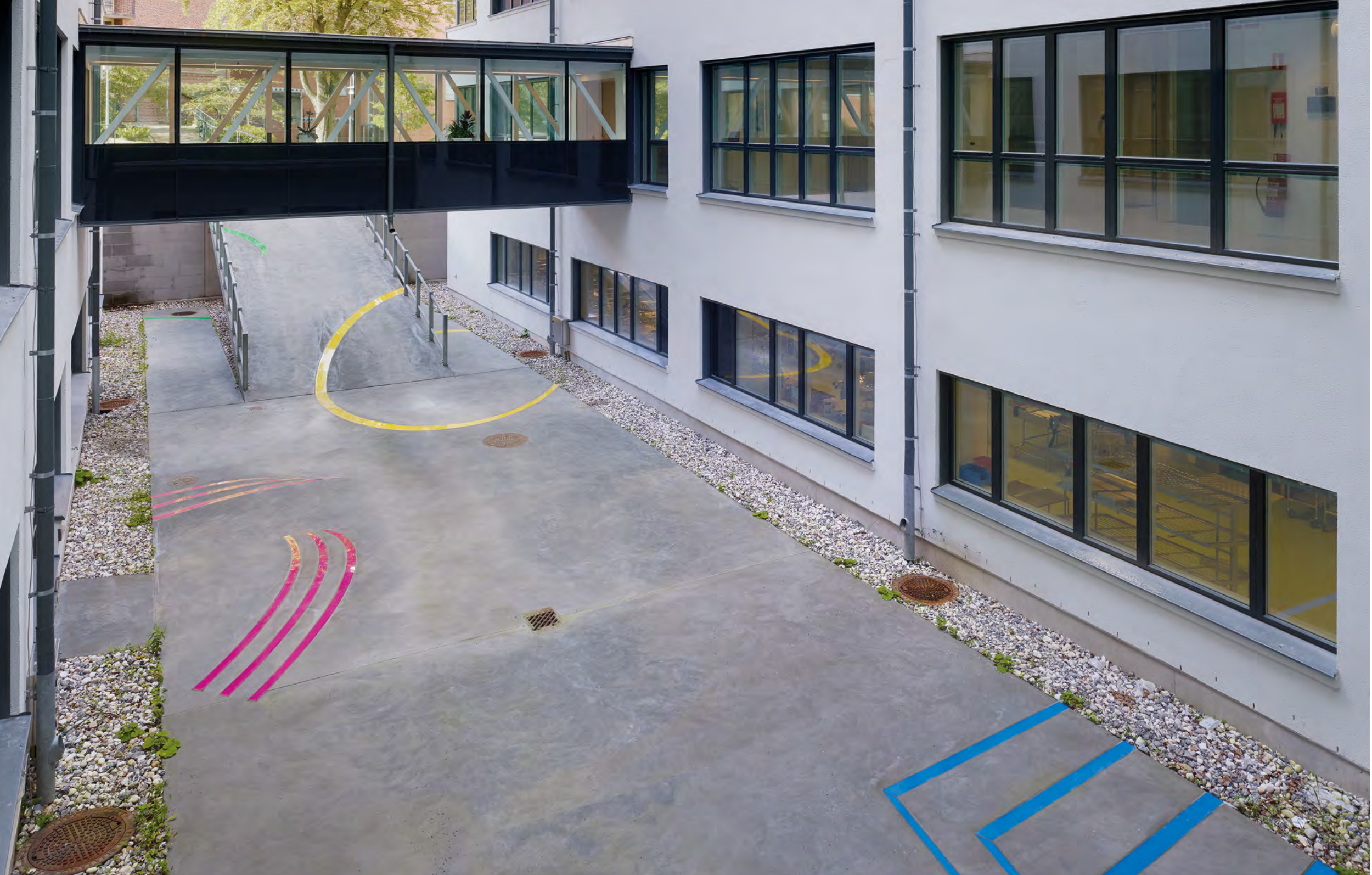
Ljusinstallationen Transmission består av färgat laminat nedsänkt i gårdens betongyta och LED-armaturer som lyser upp underifrån.
