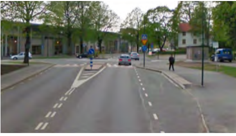
Hållplatsficka på Trandögatan.
